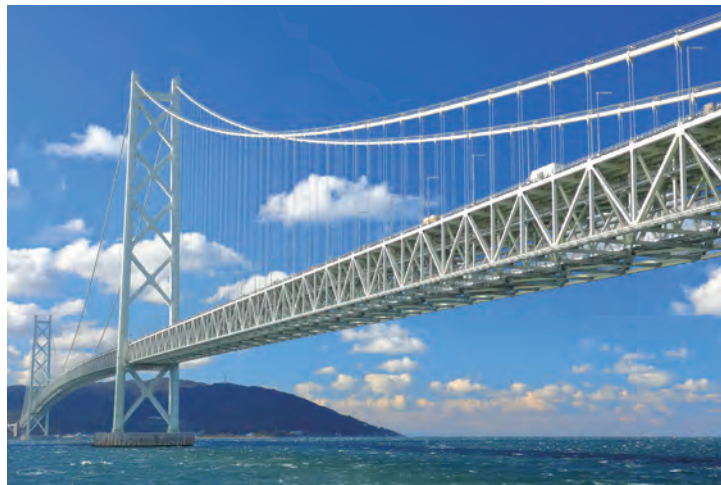
明石海峡大橋
